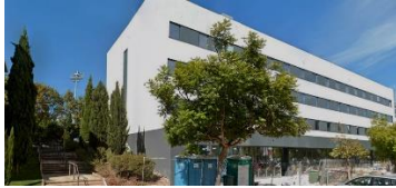
Fig. 37 Construção do CE 2
