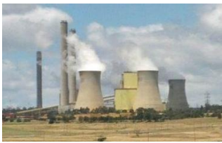
Fig.19 Usina a carvão, Mehillone, Chile
